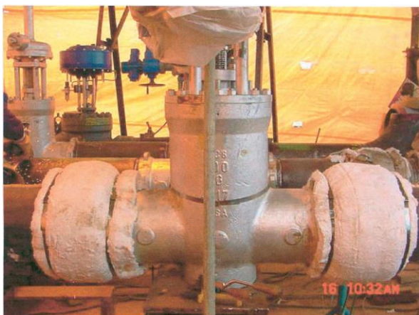
El cuerpo de válvula con montado y aislado resistencia térmicamente listo para el comienzo del tratamiento térmico sobre las uniones soldadas.
