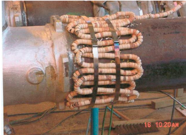
Detalle el posicionamiento de la resistencia.
