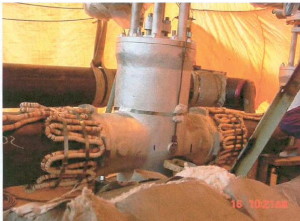
El cuerpo de válvula con la resistência em la Posición correcta sólo en las regiones de los biseles.
